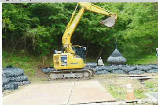
大型土のう設置
