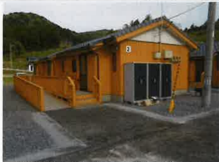
建設型応急仮設住宅(蛸ノ浦地区)
